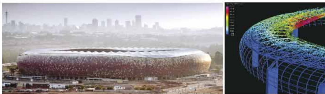
Il nuovo Soccer City Stadium di Johannesburg, uno dei più grandi stadi del mondo (94.000 posti a sedere). Dello stadio, che ospiterà la cerimonia di apertura e la finale della World Cup 2010, la Cimolai Spa di Pordenone ha realizzato e messo in opera la copertura in acciaio (8.000 ton.) e i rivestimenti (53.000 mq di membrane PTFE e 40.000 mq di pannelli in fibra di cemento).
