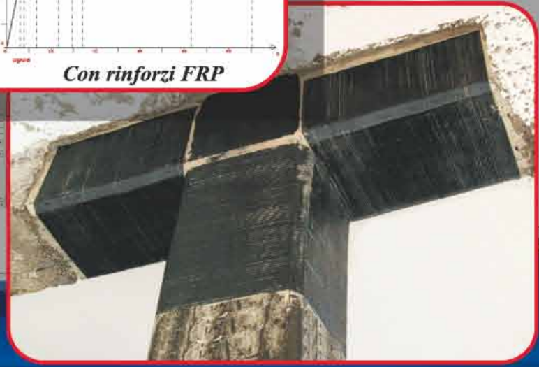
Intervento con FRP su struttura esistente in c.a.
