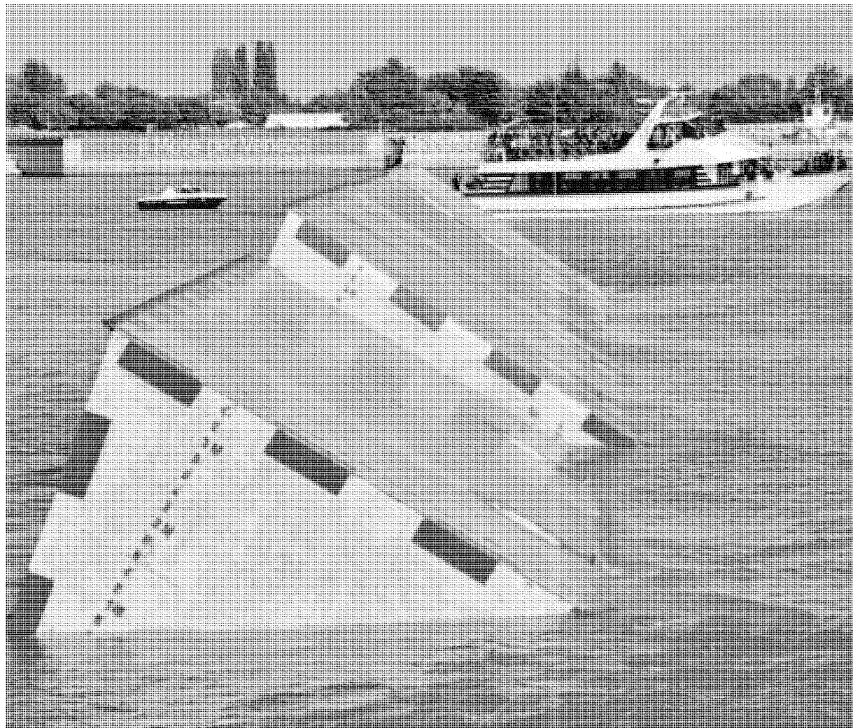
IL SISTEMA MOSE Le paratie mobili del Mose poste alla bocca del porto di Venezia durante le prime prove tecniche, lo scorso ottobre.
