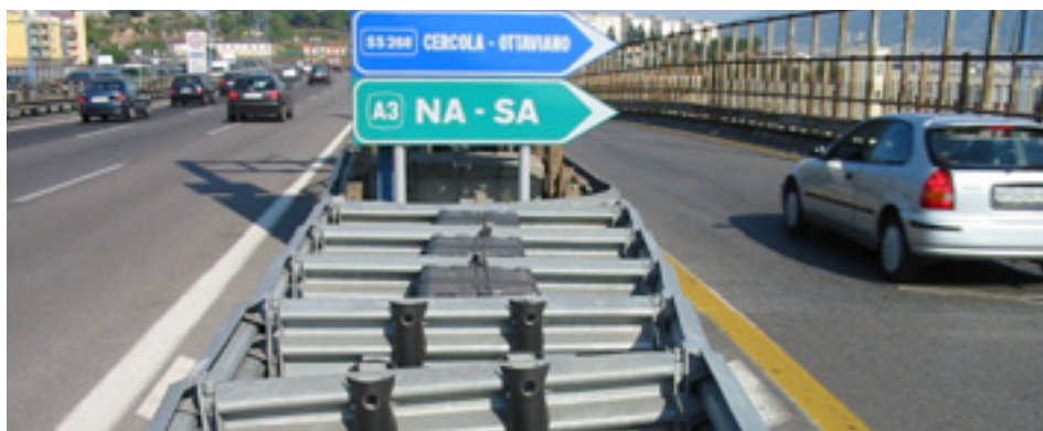
Fig. 35 - Particolare di un attenuatore danneggiato (carreggiata ovest, uscita 12 Via Campana)
