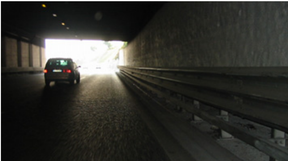
Fig. 50 - Sottopasso al km 13 + 500, carreggiata est
