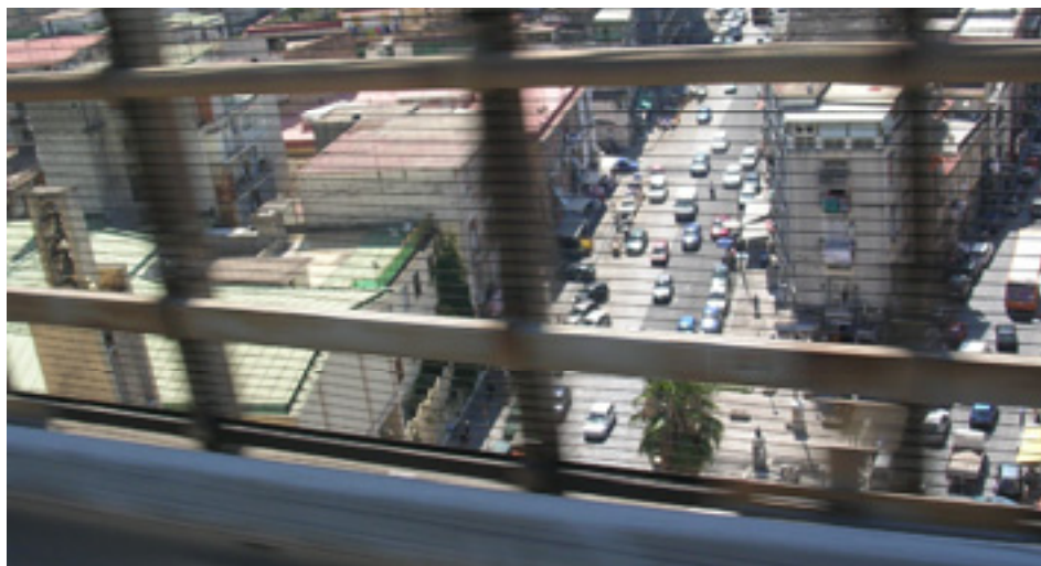
Fig. 17 - Elevata altezza del viadotto Capodichino
