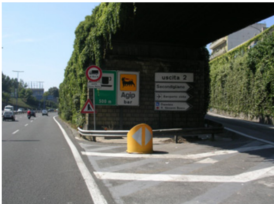
Fig. 36 - Muro ortogonale al traffico (carreggiata ovest)
