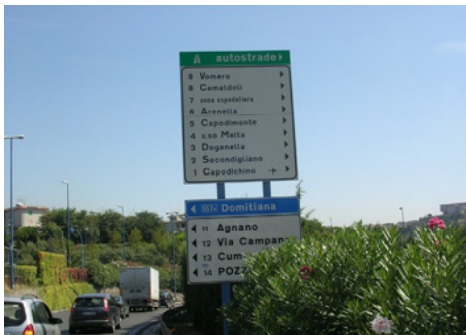
Fig. 59 - Ordine errato nell'installazione dei gruppi segnaletici (svincolo di Fuorigrotta)
