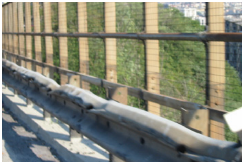
Fig. 19 - Barriera di sicurezza degradata
