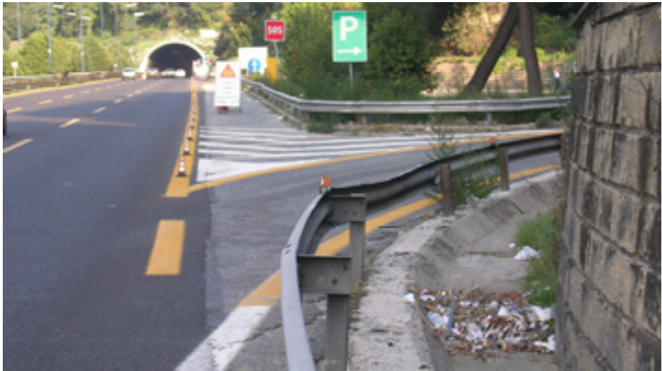
Fig. 77 - Piazzola di sosta n. 7: immissione
