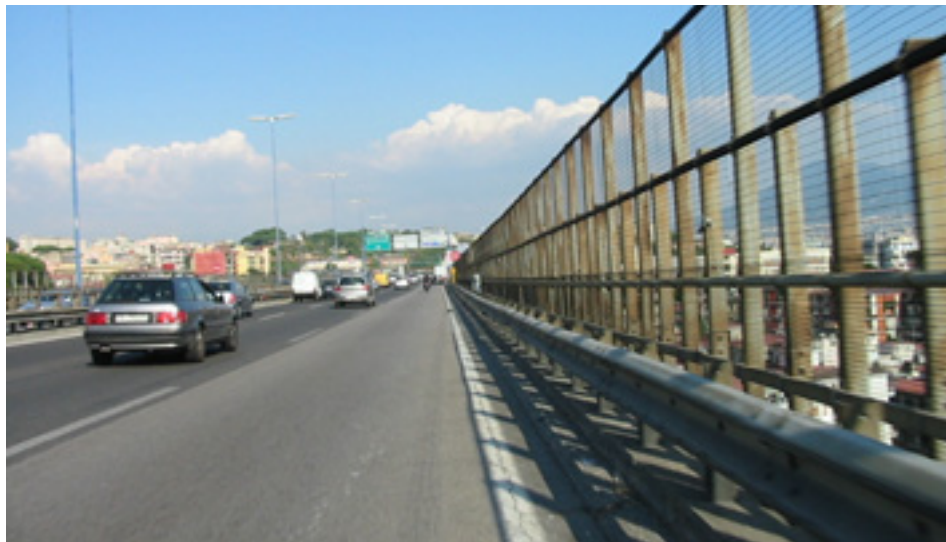
Fig. 52 - Particolare di un delineatore mancante
