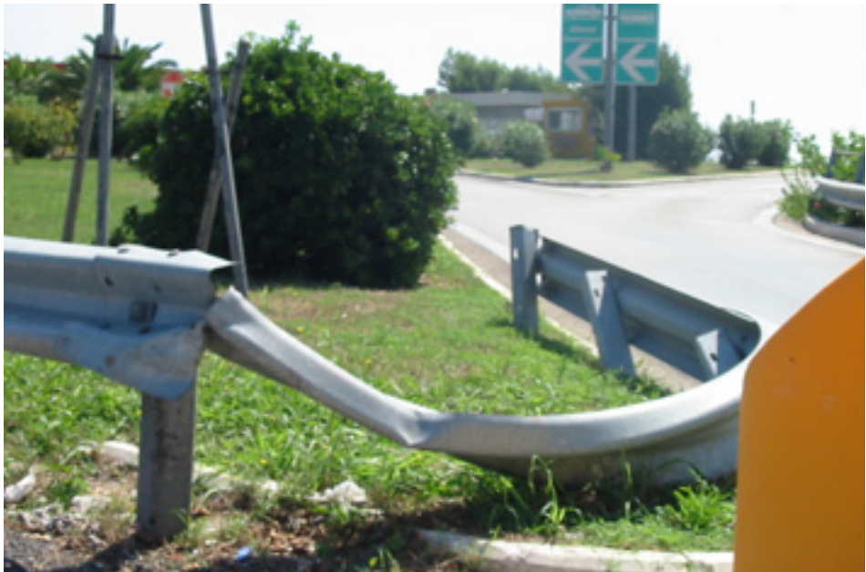
Fig. 40 - Cuspide di barriera colpita (carreggiata est, km 3 + 300)
