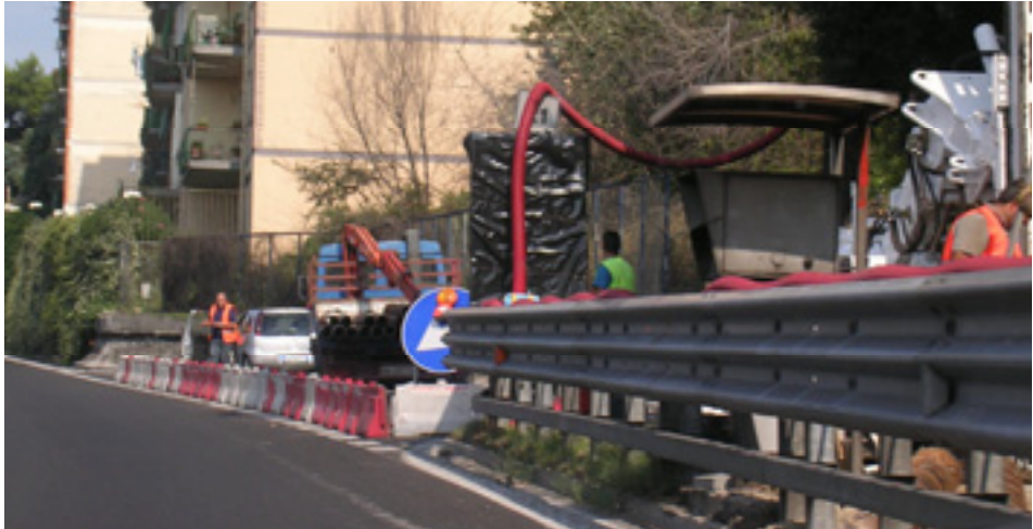
Fig. 84 - Piazzola di sosta n. 21
