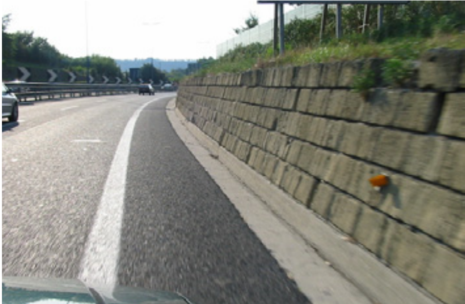
Fig. 98 - Uscita Arco Felice, carreggiata ovest (250 m prima dell'uscita)
