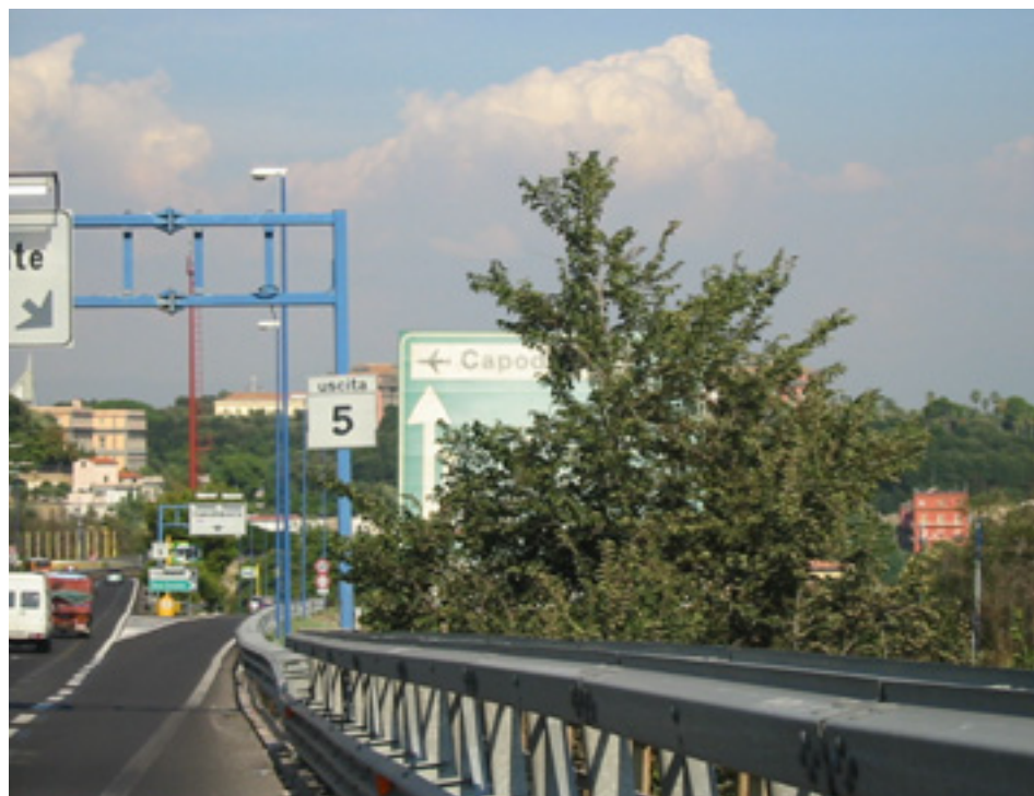
Fig. 63 - Segnale di preavviso coperto dalla vegetazione (carreggiata est, km 8)
