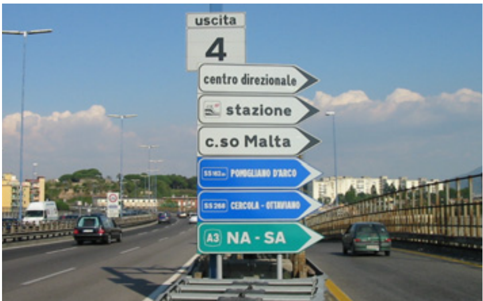
Fig. 61 - Errata disposizione per colore dei segnali (svincolo Corso Malta)
