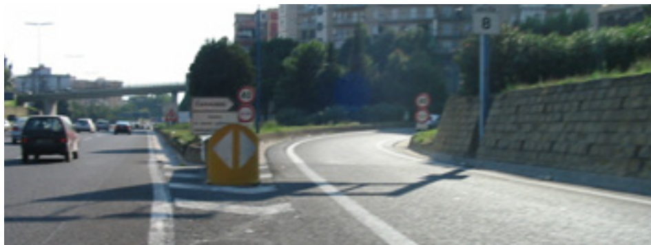
Fig. 58 - Segnale di direzione non visibile (carreggiata ovest, uscita 12 via Campana)
