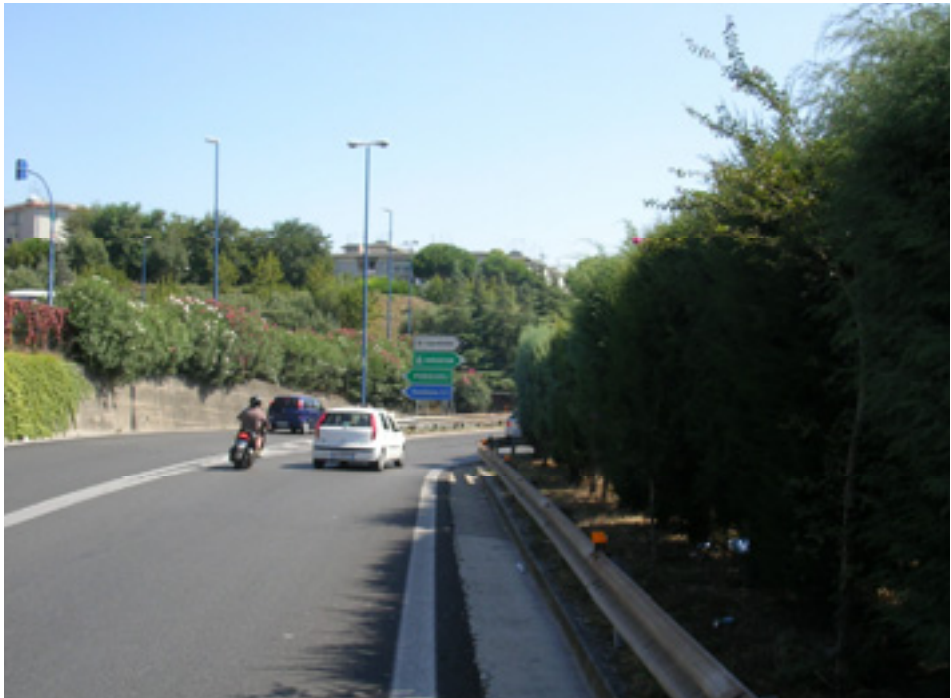
Fig. 61 - Errata disposizione per colore dei segnali (svincolo Corso Malta)
