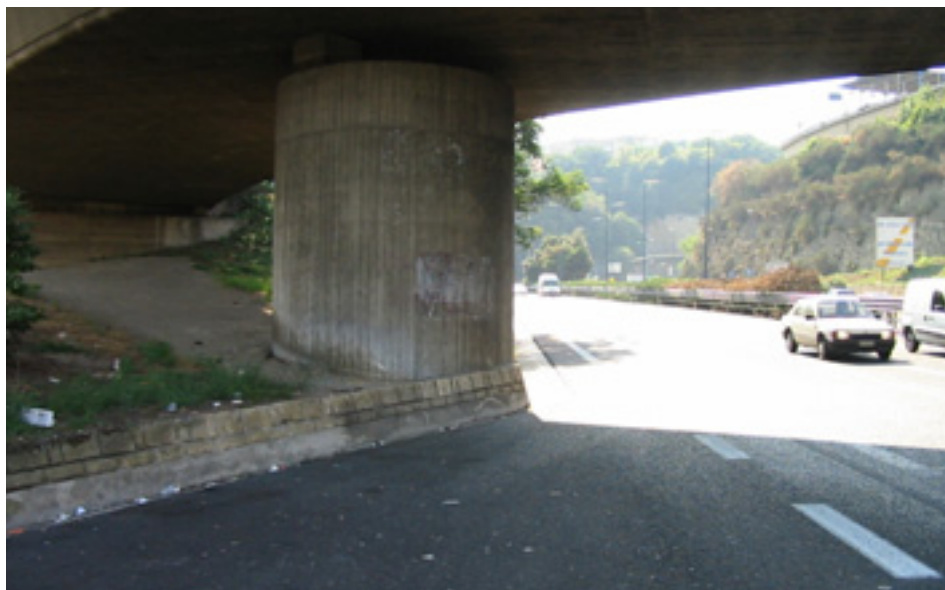
Fig. 88 - Piazzola di sosta n. 27
