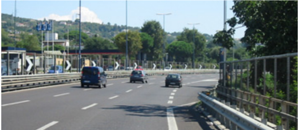
Fig. 75 - Mancanza di visibilità dell'immissione all'area di servizio "Antica Campana"
