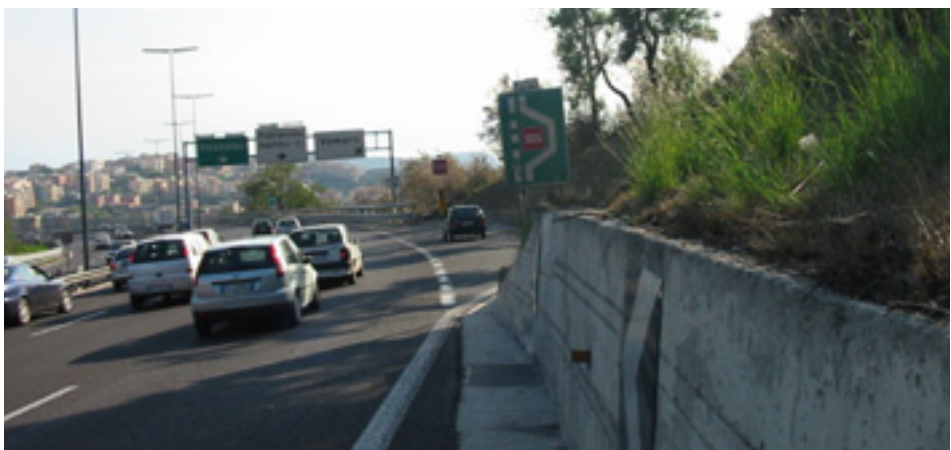
Fig. 83 - Piazzola di sosta n. 20
