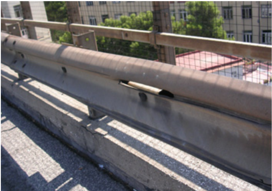
Fig. 21 - Barriera di sicuezza degradata
