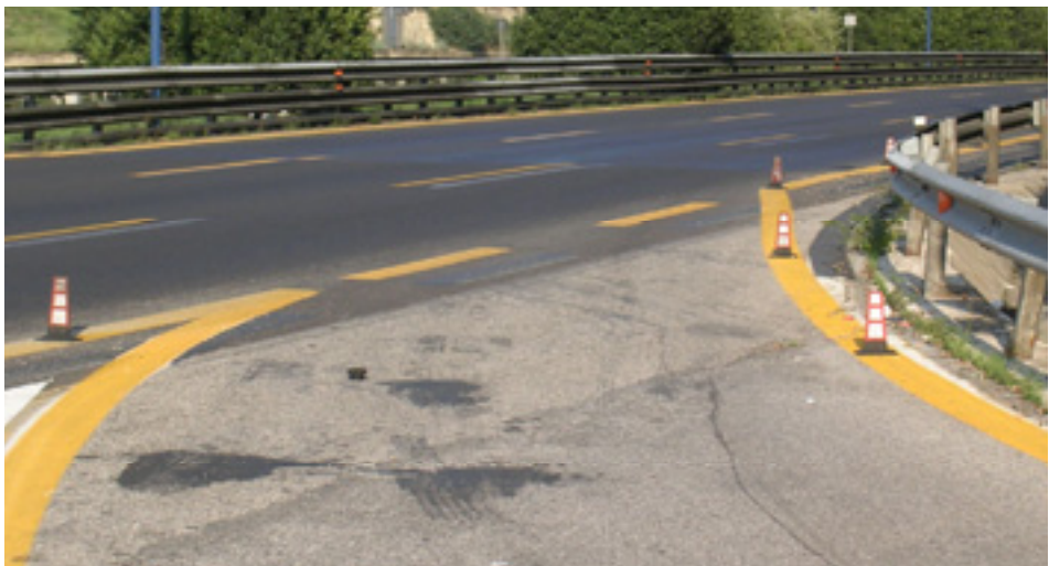
Fig. 78 - Piazzola di sosta n. 7: uscita
