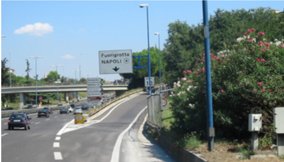
Fig. 96 - Uscita Fuorigrotta, carreggiata est
