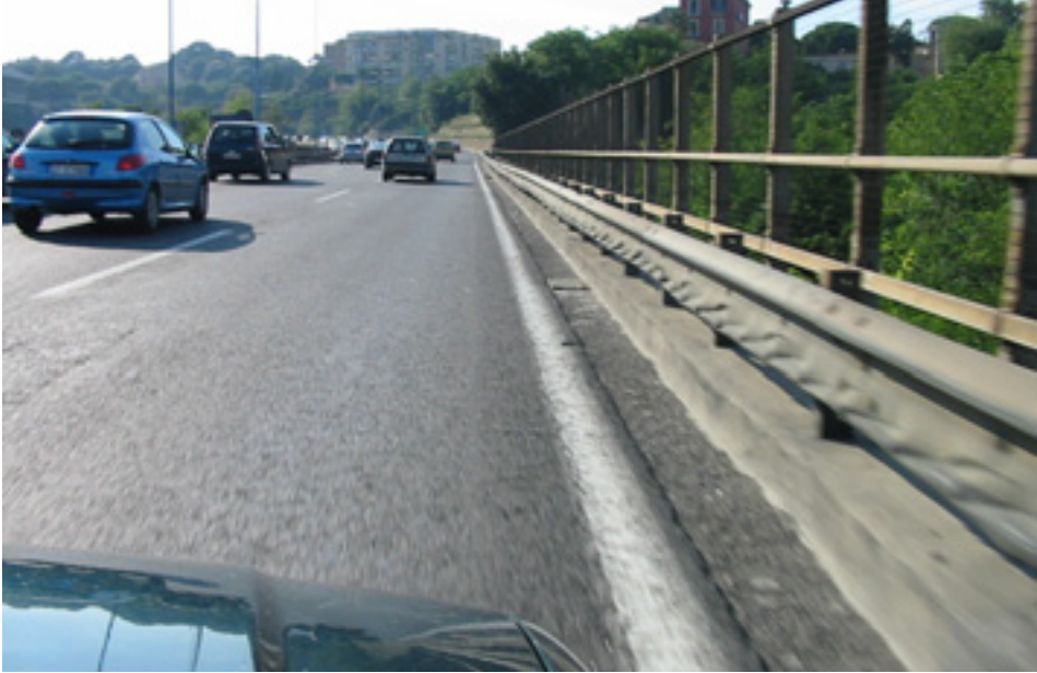
Fig. 21 - Barriera di sicuezza degradata
