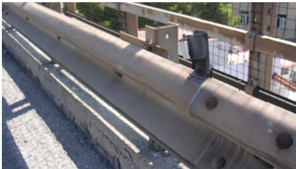
Fig. 52 - Particolare di un delineatore mancante
