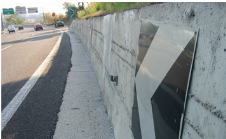
Fig. 48 - Delineatori poco visibili
