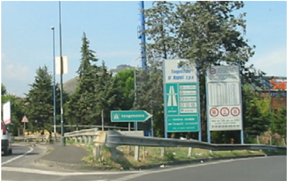
Fig. 32 - Terminale pericoloso (svincolo Fuorigrotta)
