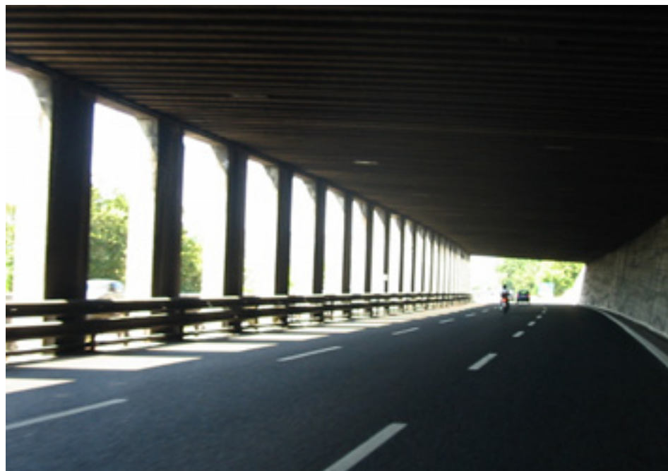
Fig. 46 - Assenza di delineazione
