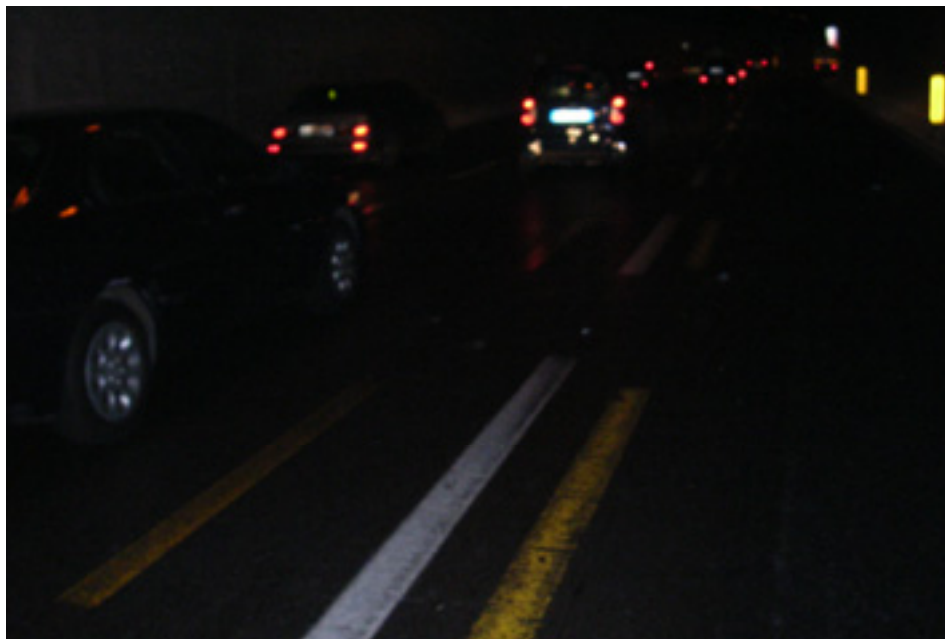
Fig. 72 - Coesistenza di segnaletica permanente e provvisoria (galleria Capodimonte, carreggiata est)
