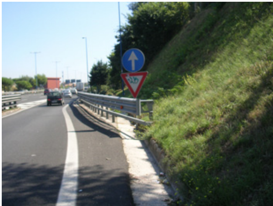
Fig. 62 - Segnale di obbligo installato prima del segnale di precedenza (ingresso da Fuorigrotta in direzione est)
