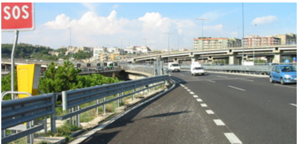
Fig. 85 - Piazzola di sosta n. 24
