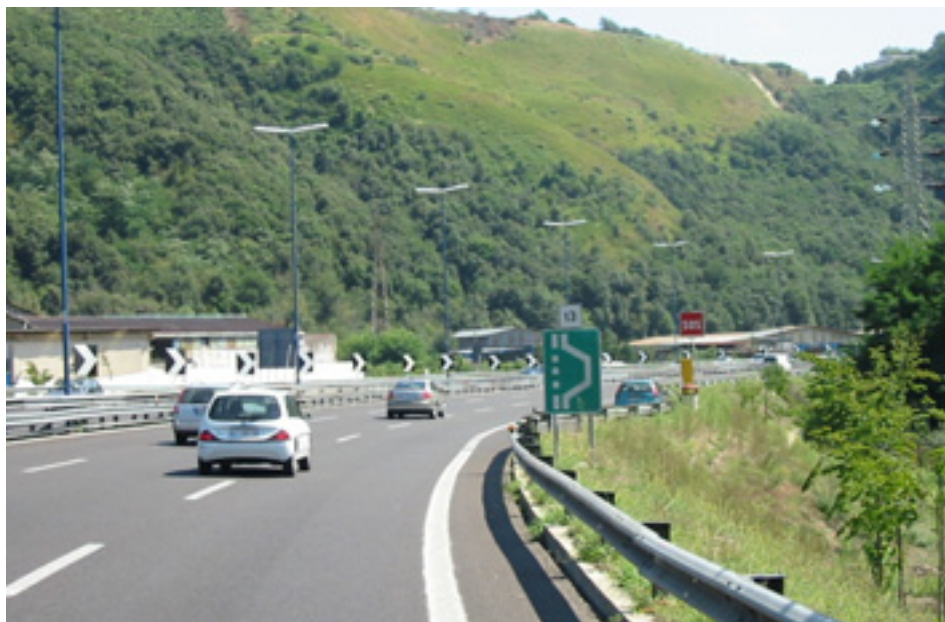
Fig. 79 - Piazzola di sosta n. 13
