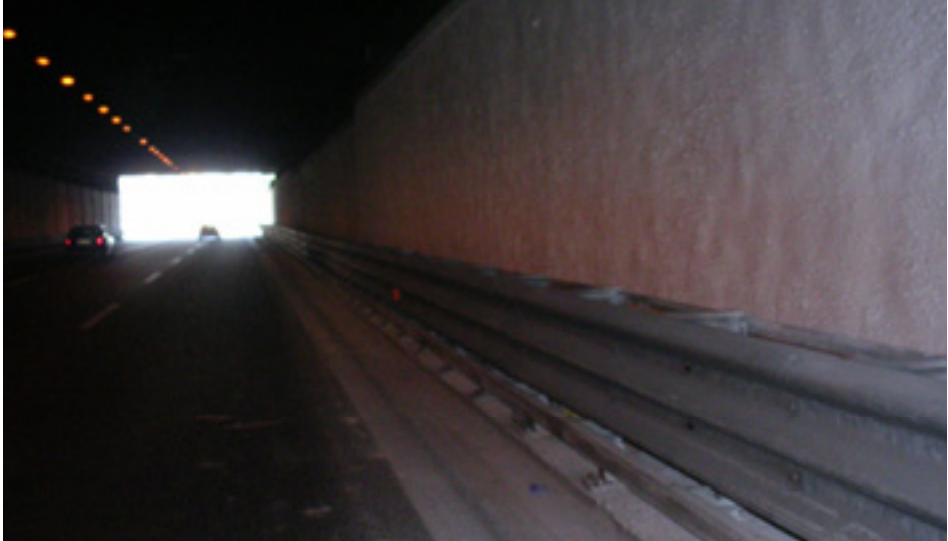
Fig. 49 - Sottopasso al km 13 + 500, carreggiata ovest
