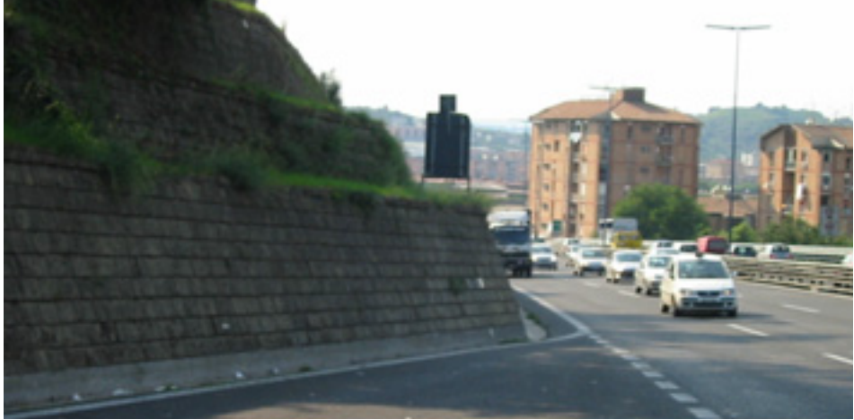
Fig 82 - Piazzola di sosta n. 17
