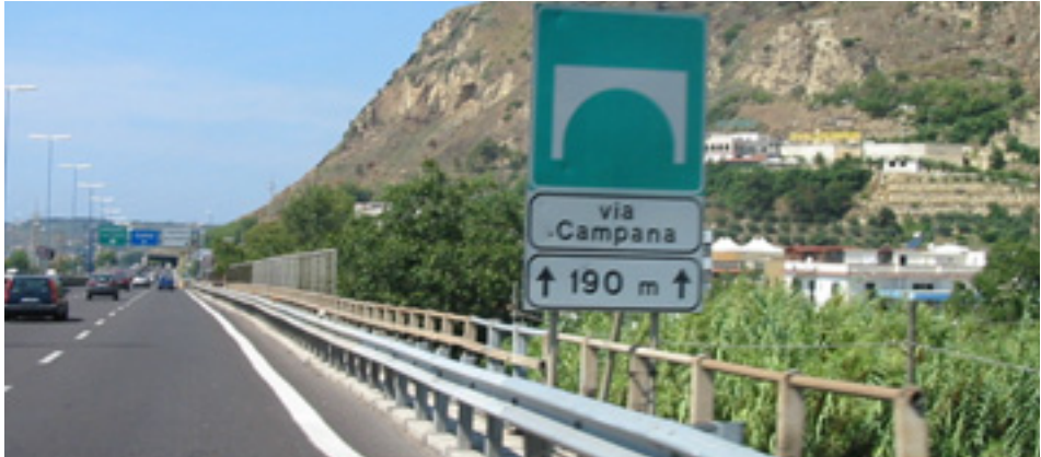
Fig. 22 - Viadotto via Campana: barriera di sicurezza con bassa capacità di contenimento
