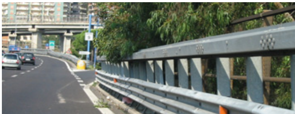
Fig. 57 - Segnale di direzione non visibile (carreggiata ovest, uscita 8 Camaldoli)
