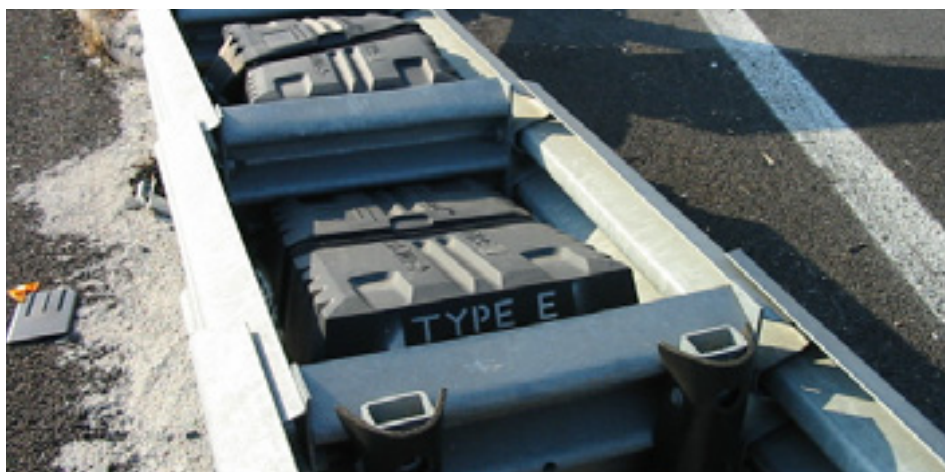
Fig. 35 - Particolare di un attenuatore danneggiato (carreggiata ovest, uscita 12 Via Campana)
