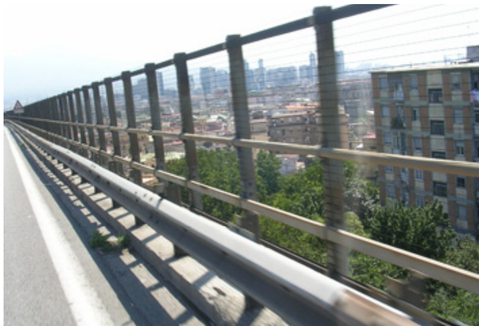
Fig. 19 - Barriera di sicurezza degradata
