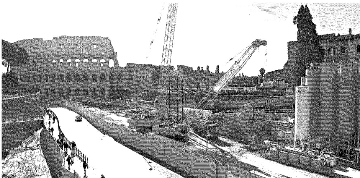
▲ Cantiere Il cantiere per la metro C su via dei Fori imperiali
