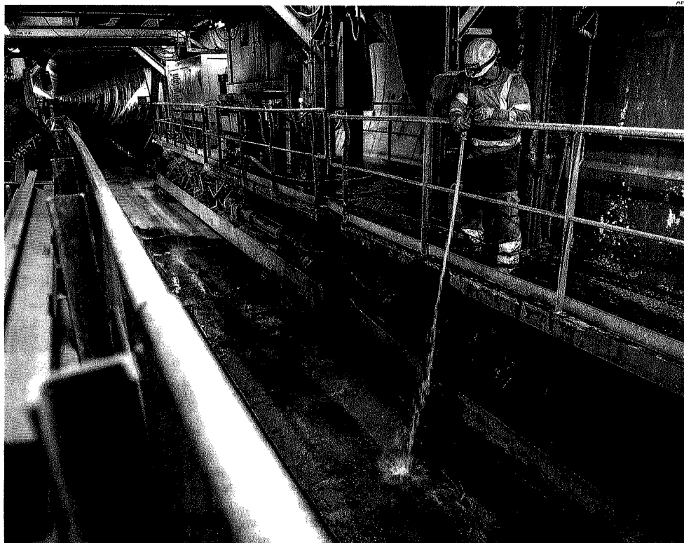
Nel cantiere della Tav. Sono 700 gli operai al lavoro sulla Torino Lione
