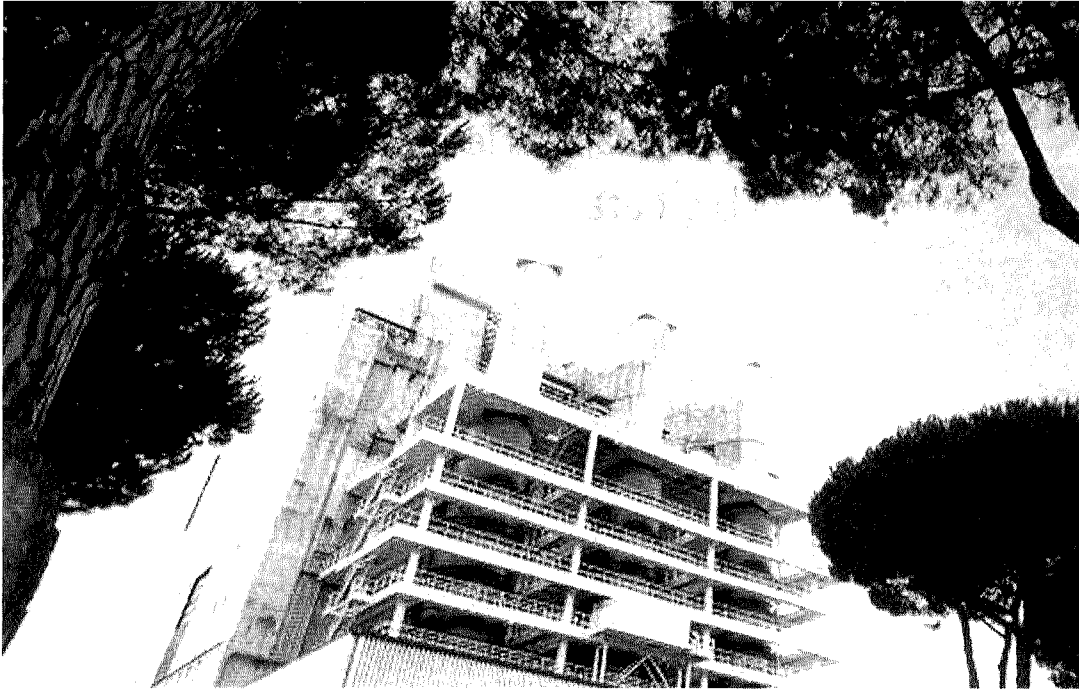
Prima in Italia. L'edificio del reattore della centrale costruita nel 1958
