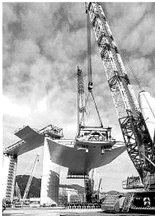
Il cantiere I lavori per il ponte (foto Filippo Vinardi)
