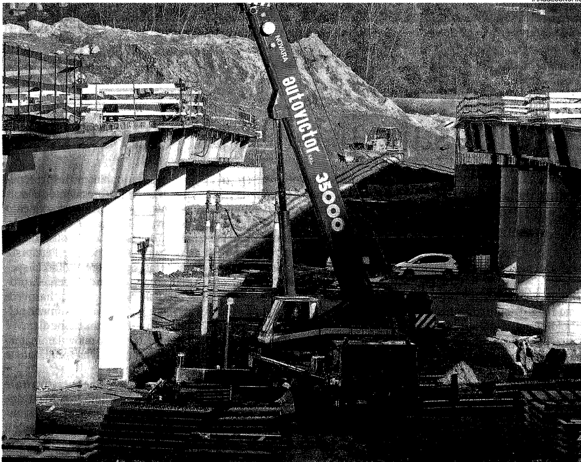
Grandi opere. Nella foto del 2013 il cantiere della Pedemontana tra la tangenziale di Como e Grandate
