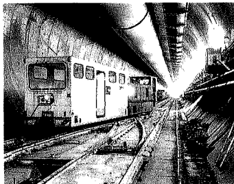
Il cantiere si ferma
