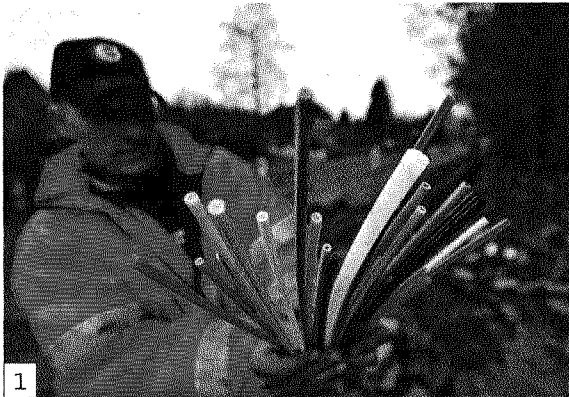
1 Un operaio al lavoro per la posa di nuove reti in fibra ottica che possono garantire banda fino a un giga
