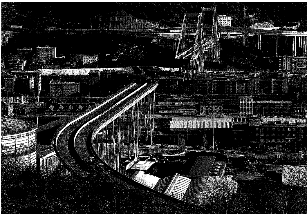
Ricostruito Il ponte Morandi, crollato il 14 agosto del 2018 causando la morte di 43 persone, è stato demolito e ricostruito in meno di due anni (Ansa)
