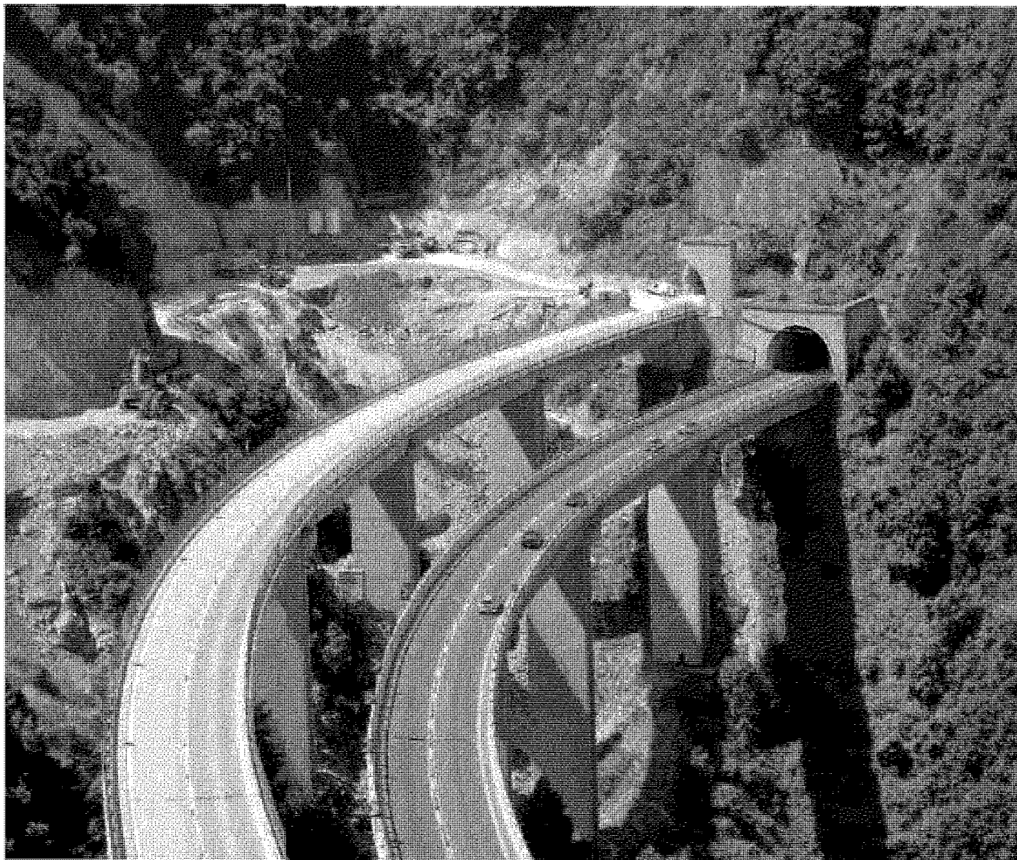
Un tratto dell'autostrada Salerno-Rossano Calabria
