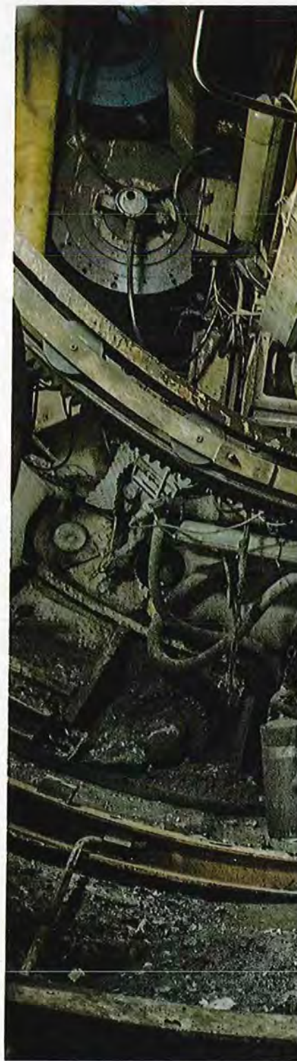
Un operaio nella galleria di Chiomonte con dietro la talpa Gea. Qui la temperatura sfiora i 45 gradi
