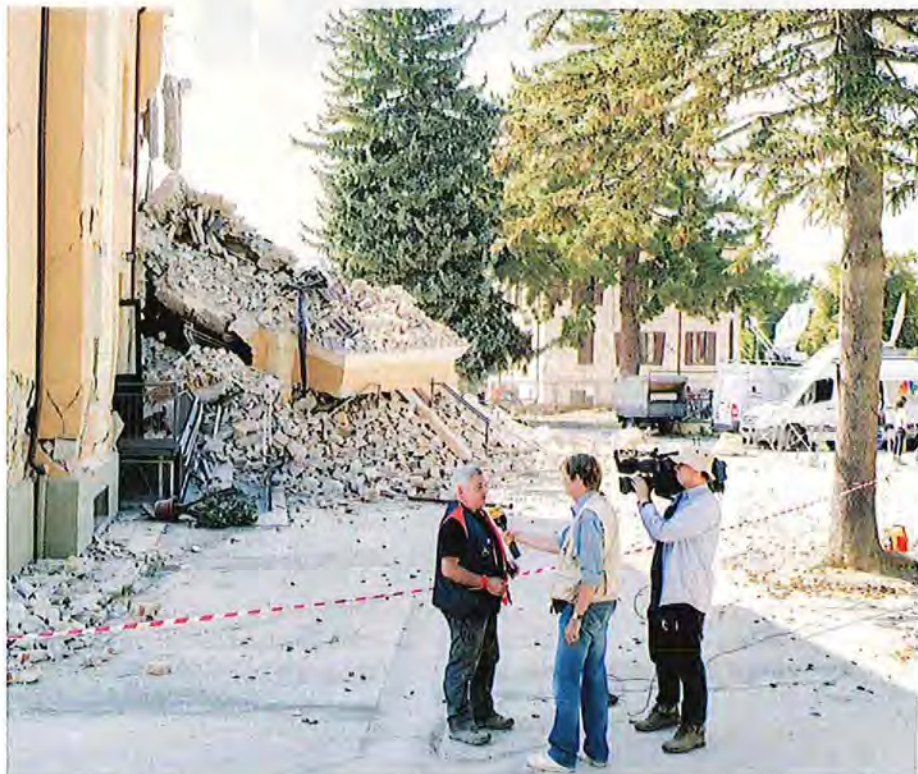
La scuola crollata di Amatrice, città simbolo del terremoto del 24 agosto
