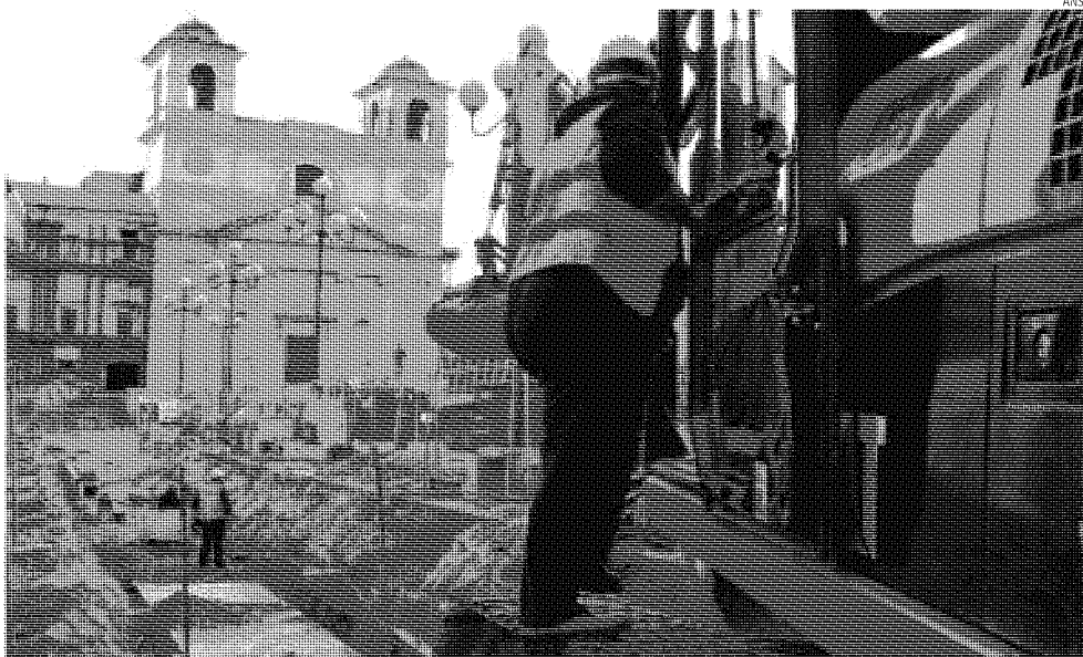
Ricostruzione. I cantieri della ricostruzione dell'Aquila
