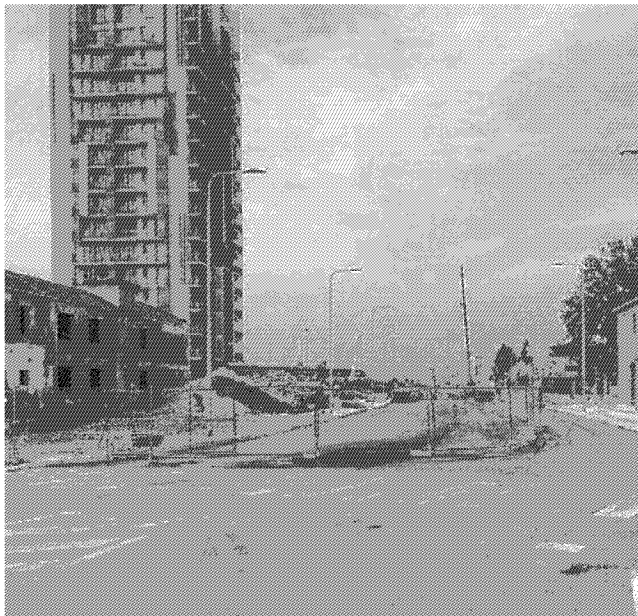
Lavoro in corso. La strada alternativa al sottopasso della Zara-Expo. Si vedono sullo sfondo i cantieri interrotti e capannoni abbandonati. La strada transennata verrà aperta il 26 aprile per permettere una viabilità transitoria verso la porta Est del sito espositivo
