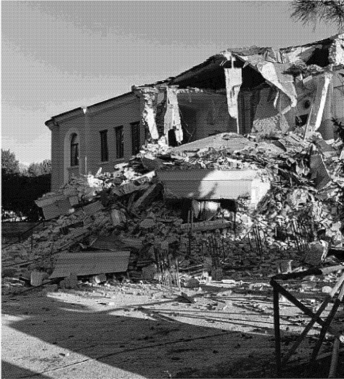
Macerie La scuola di Amatrice crollata dopo il terremoto
