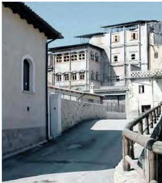
Nella combo: a sinistra uno scorcio di Tempera, frazione dell'Aquila gravemente danneggiata dal sisma e a destra la stessa strada come è oggi (foto ANSA)
