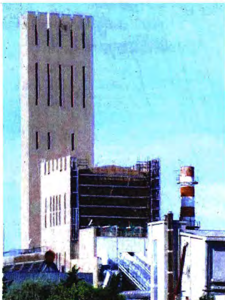
Impianto moderno Il termovalorizzatore Hera a Coriano (Rimini)
