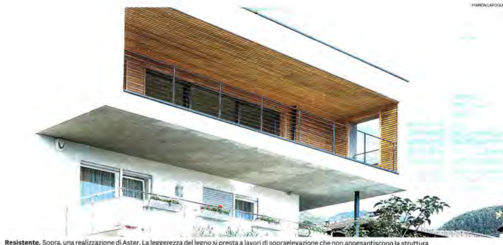
Resistente. Sopra, una realizzazione di Aster. La leggerezza del legno si presta a lavori di sopraelevazione che non appesantiscono la struttura
