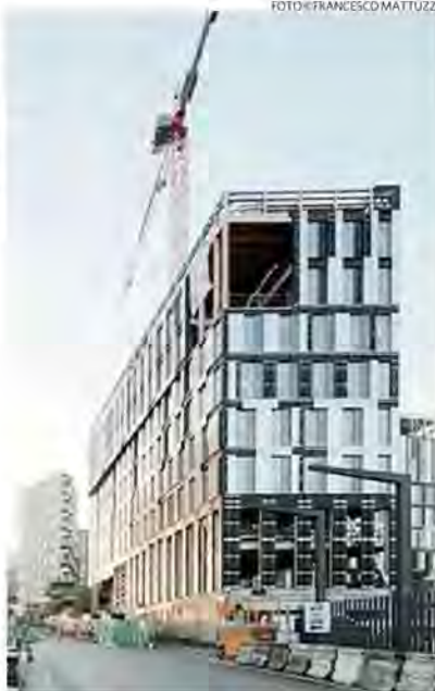
In costruzione. Un edificio del cantiere di Clichy-Batignolles che chiuderà nel 2019
