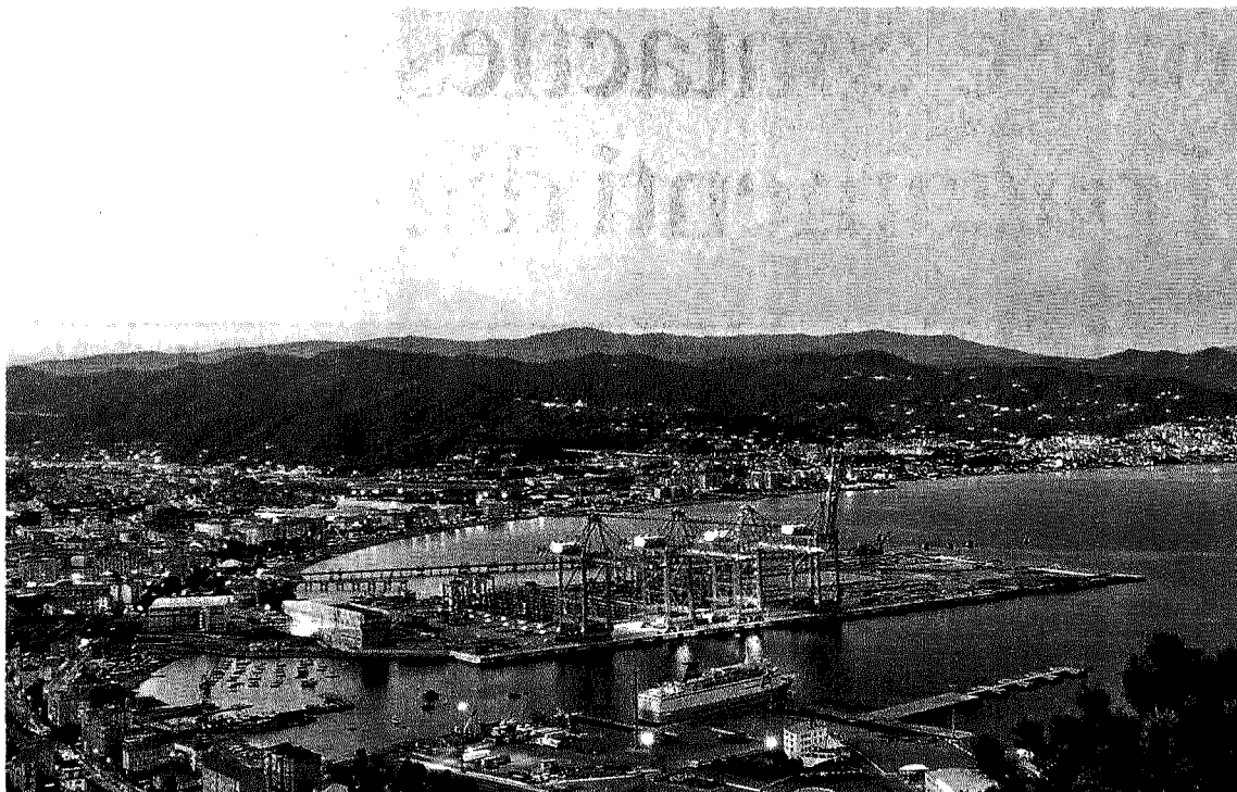
La nuova infrastruttura a Savona. Il terminal di Vado Ligure inaugurato ieri
