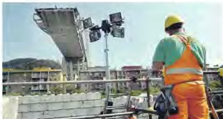
Operai al lavoro sotto il ponte Morandi
