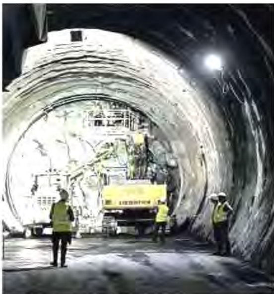
Un cantiere della Tav nella parte francese dei lavori dall'Alta velocità
