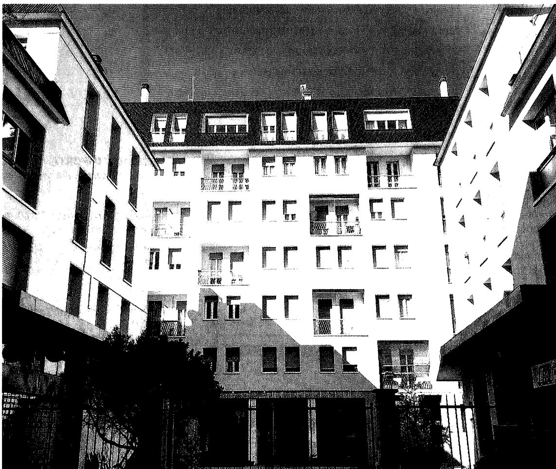
A Milano. La riqualificazione del condominio degli anni Settanta di via Passeroni, conclusa a giugno, ha permesso di passare dalla classe energetica F alla C, con taglio di due terzi dell'energia utilizzata. Le fasi di cantiere sono state gestite da Teicos con Bi-Smart, progetto finanziato dalla Regione Lombardia
