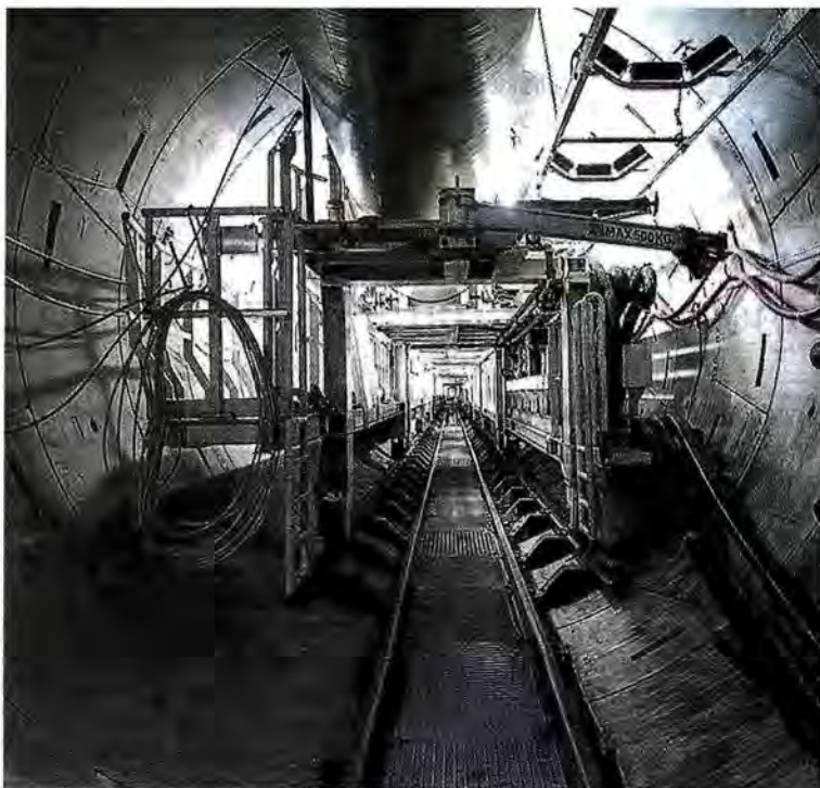
Salini Impregilo. Il tunnel idraulico di 12 Km in costruzione a Buenos Aires
