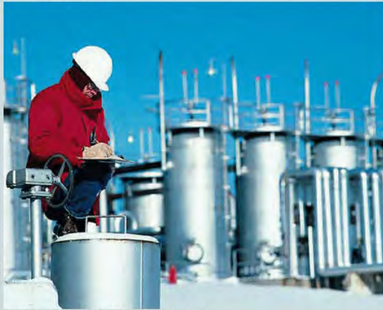
Una centrale di stoccaggio lungo un gasdotto
