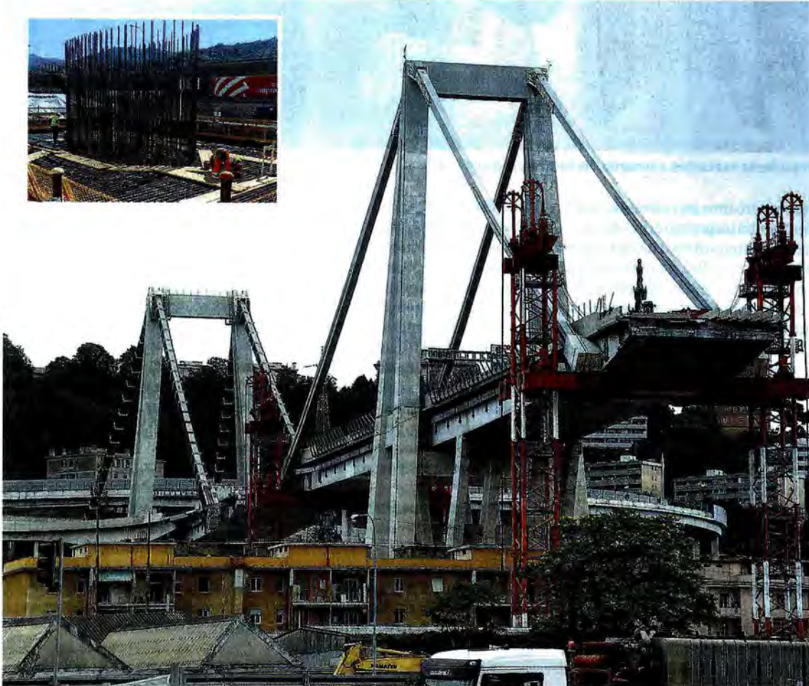
Pronto alla demolizione. Il Ponte pronto alla demolizione. Nel riquadro l'armatura del primo pilone della nuova struttura
