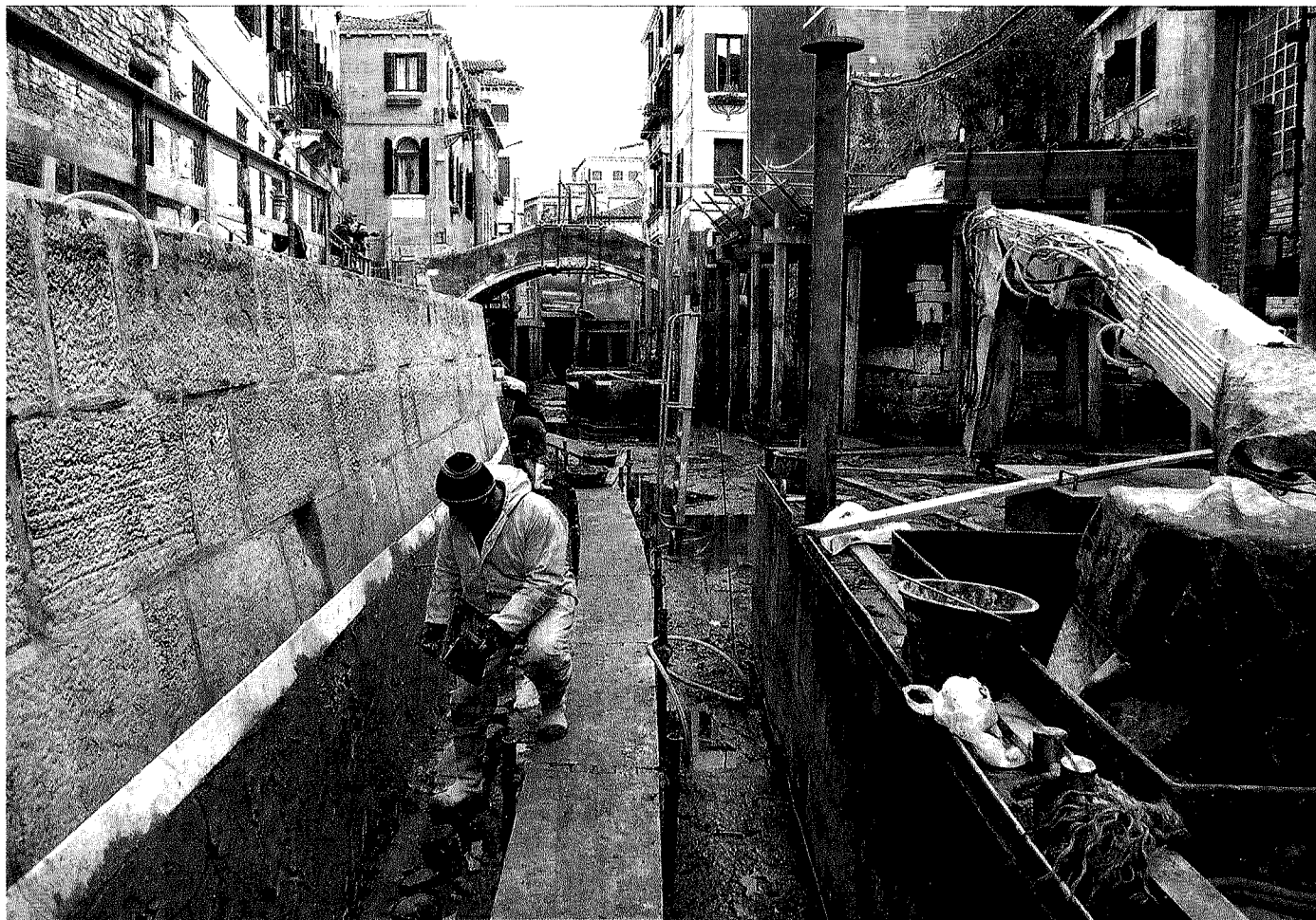
Emergenza in laguna. Lavori di manutenzione alle scarpate di protezione dei palazzi in un canale di Venezia
