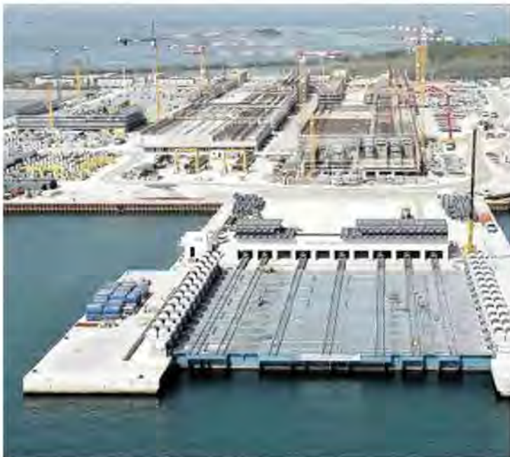
Una panoramica del Mose a Venezia
