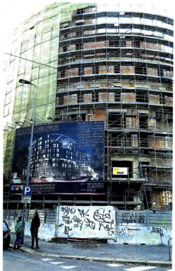
Milano. Il cantiere delle residenze Carlo Erba (Città Studi) è stato fermo a lungo
