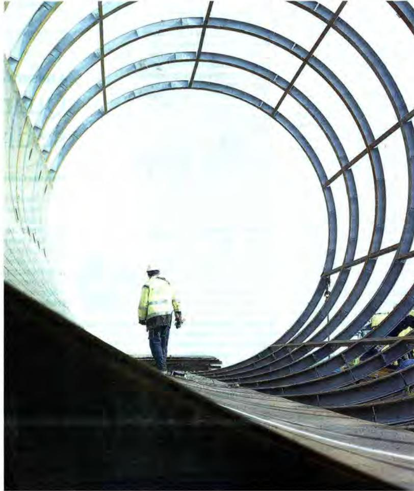
**Energia green.** Uno dei quattro digestori orizzontali (nella foto di Silvia Camporesi, ancora in fase di realizzazione) dell'impianto per la produzione di biometano del Gruppo Hera a Sant'Agata Bolognese, dove i rifiuti organici sono soggetti a un processo di biodigestione anaerobica per la produzione di biogas. I residui diventano compost fertilizzante di qualità
