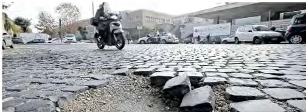
Strada dissestata in via di Porta San Lorenzo, alle spalle della stazione Termini (foto ANSA)
