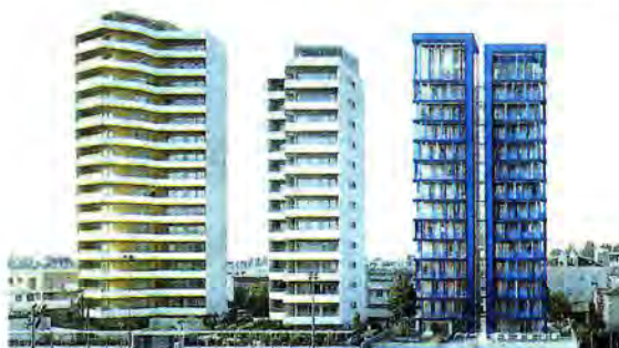
In cantiere. La Cross Lam Tower di Jesolo (a destra) firmata da Demogo e promossa da Urban-Bio, 14 piani in legno
